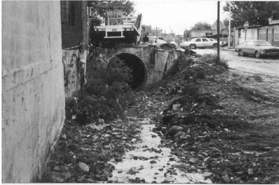
A.3 Alcantarilla para el afluente del arroyo El Seco.
