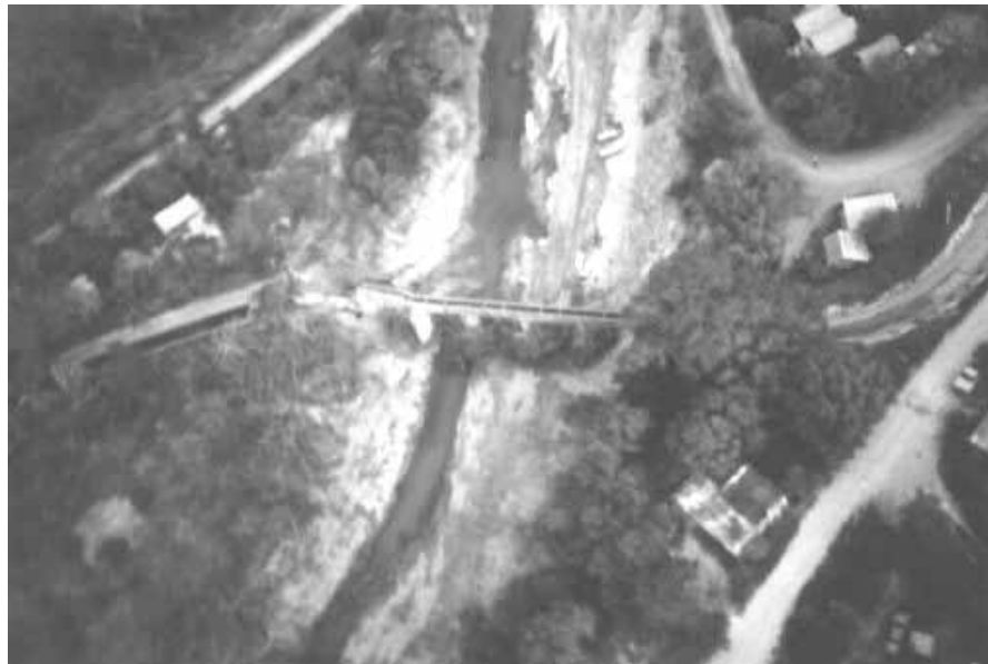
A.16 Vista aérea de un acueducto cercano a San Manuel. Se observa la acumulación de ramas y troncos en las pilas que lo sostienen. El nivel de agua seguramente sobrepasó los 4 m, y el ancho del cauce fue cinco veces su tamaño actual.
