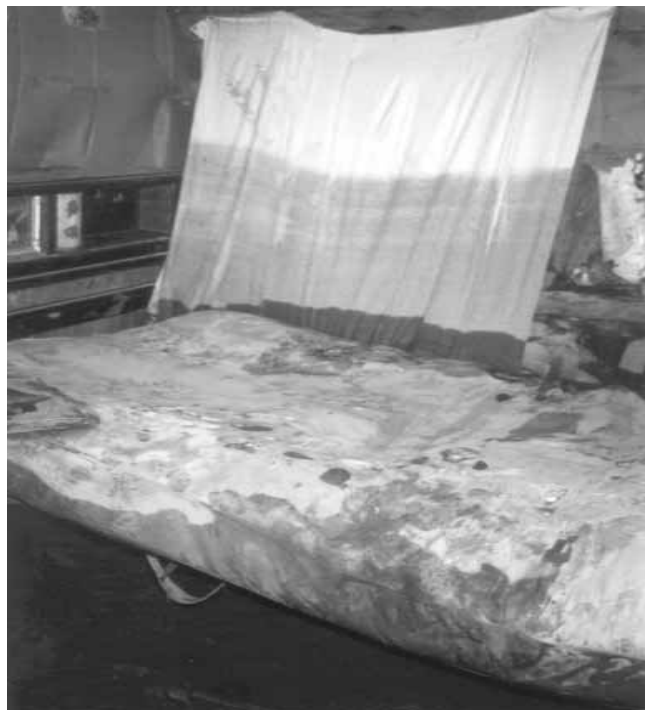
A.28 Daños producidos en el interior de una vivienda en San Manuel
