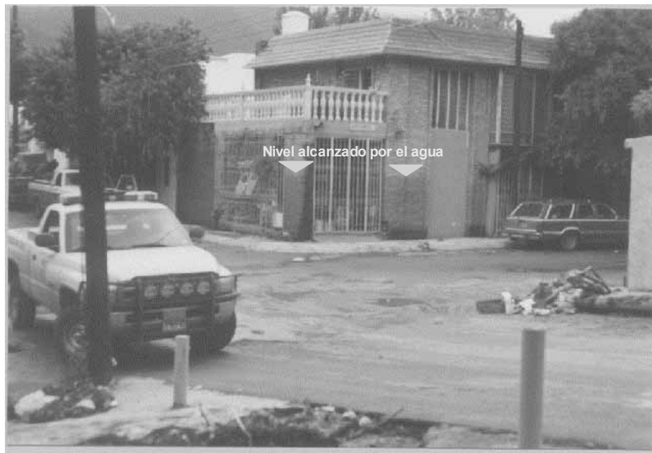
A.8 En esta imagen se observa el nivel alcanzado por el agua en la esquina de Santa Rosalía y Vizcaíno.
