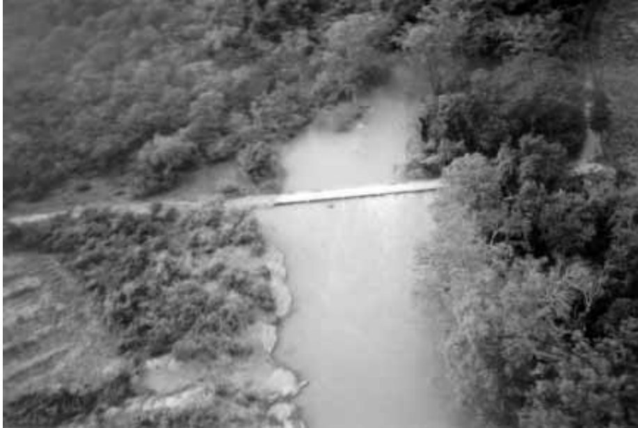
A.21 Puente sobre el río Sabinas
