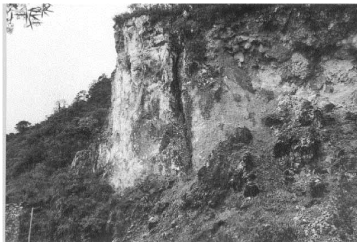
A.12 Corte vertical con facturas longitudinales en proceso de falla por volteo, ubicado a un costado de la Av. San Ángel.
