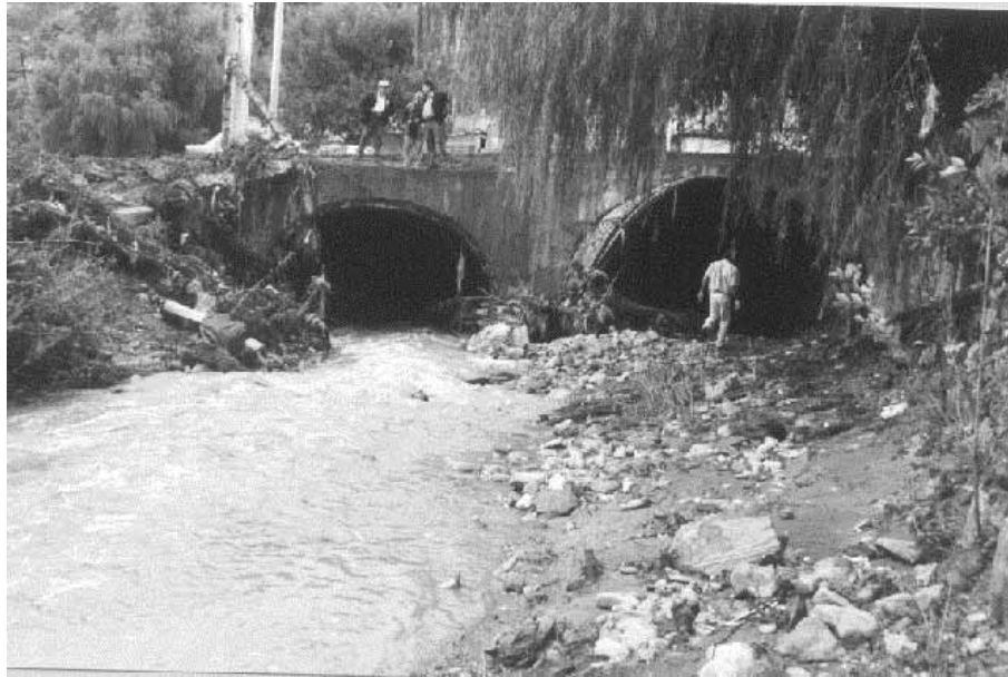
A.1 Alcantarillas a la entrada de la confluencia del arroyo El Seco, a la altura del cerro La Campana.
