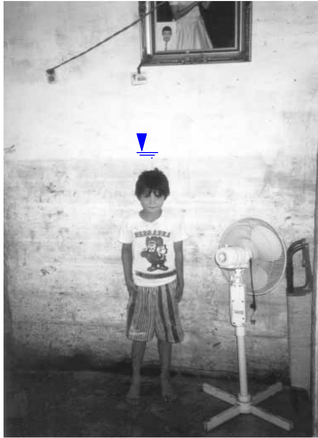
A.29 Marca del nivel de agua que dejó la creciente del río Sabinas en San Manuel. La casa donde se tomó la foto está elevada 50 cm aproximadamente del nivel del terreno
