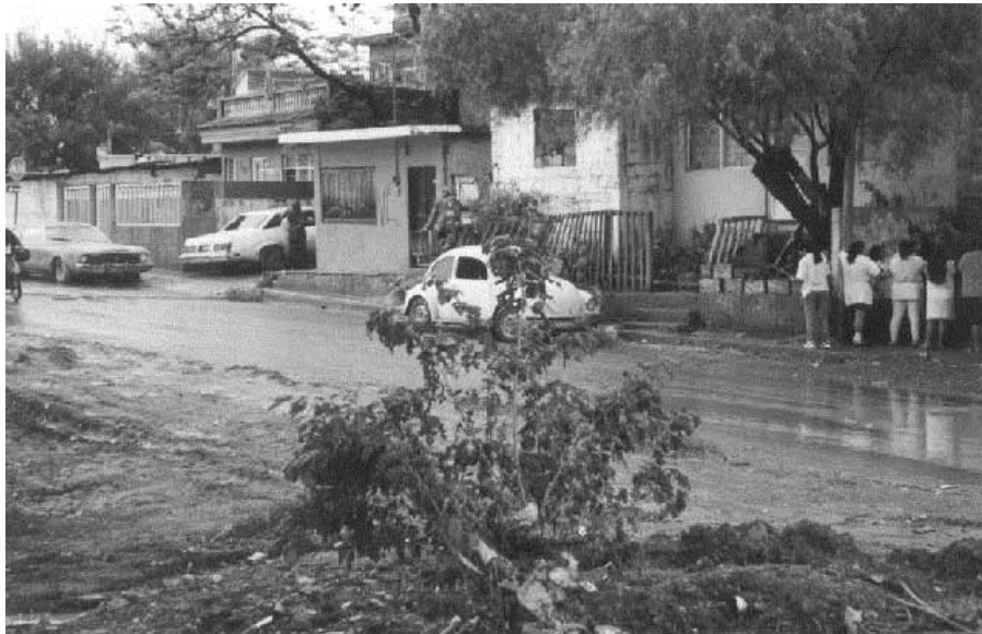
A.4 Casas con riesgo de inundación, ubicadas en la margen derecha del afluente del arroyo El Seco.
