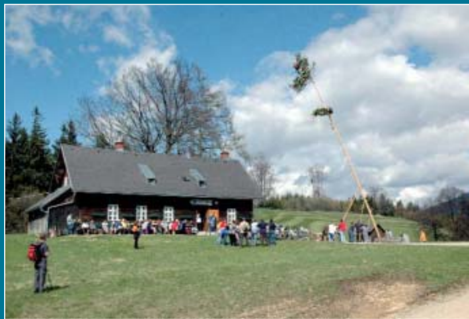
Die Almhütte, welche sich im Besitz der Stadt Bruck befindet, wurde in den vergangenen Jahren umfassend renoviert. Das Gasthaus soll demnächst auch eine Photovoltaikanlage zur umweltschonenden Stromerzeugung bekommen. Öffnungszeiten: Dienstag bis Sonntag.
