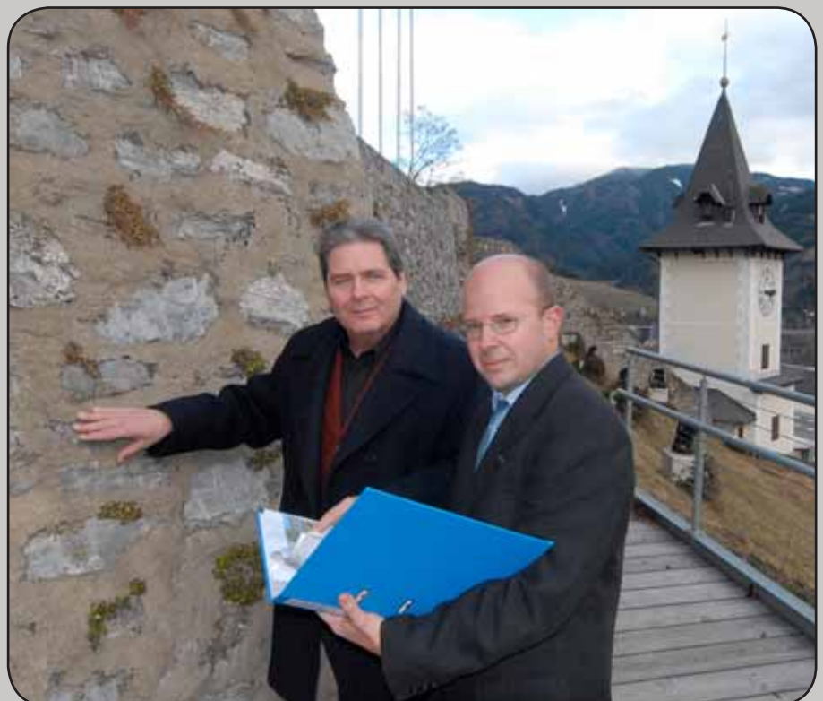
DI Andreas Pachner vom Baureferat erklärt den Zustand der Mauer.
