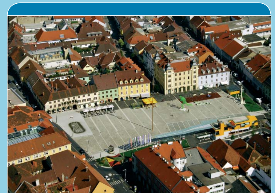
Auch aus der Luft ein Blickfang für das Auge: der neue Koloman-Wallisch-Platz präsentiert sich in neuem Glanz.
