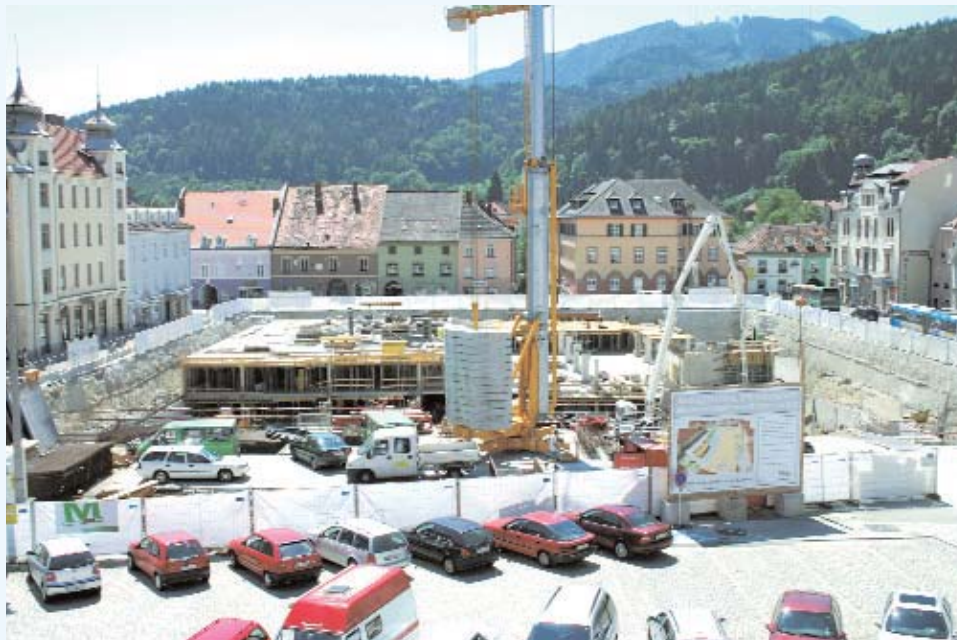
Ein Platz für enorme Vielfalt und Lebensqualität wird hier entstehen. Die Bauarbeiten liegen exakt im Zeitplan und die Tiefgarage wird im Herbst den Betrieb aufnehmen.
