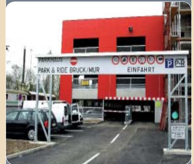
Das neue zweistöckige Parkdeck beim Bahnhof Bruck an der Mur wird den Pendlern und Bahnreisenden zukünftig den Umstieg in die umweltfreundliche Bahn erleichtern.
