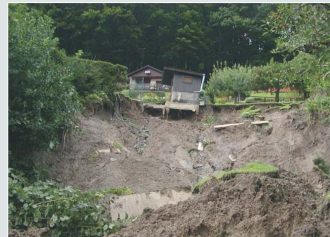
Hangrutschung bei den Kleingärten auf dem Pfarrgrundstück am Kreckler. Über den Krecklerweg rutschte ein Teil des Hanges in einen darunter liegenden Kleingarten. Der Weg wurde vom Bauhof sofort wieder freigemacht. Mit verschärft wurde die Situation sicher auch durch den darüber liegenden Forstweg (Liegenschaft der Diözese), der hier unzureichend entwässert wurde.
