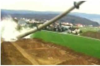
Sprengung eines Sendeturms
