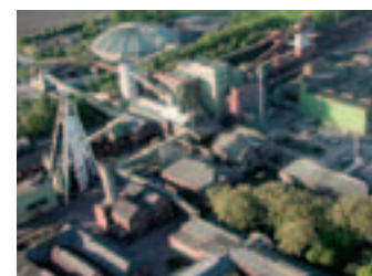
1-MW-Versuchsanlage in Dorsten
