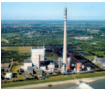
Modernisiertes Kohlekraftwerk in Wilhelmshaven
