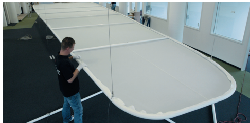
Baustellenidylle (oben), Segel unter der Decke schlucken den Schall
