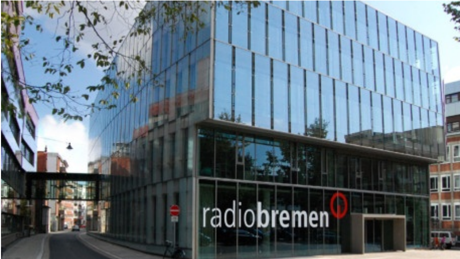
Fassade Haus Diepenau, Radio Bremen
