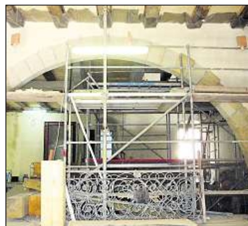
Erdgeschoss, Blick vom Portal ins Gebäudeinnere
