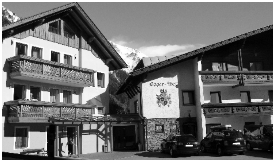
Foto: Neubau und Nebenhaus Gasthof Pension Restaurant Eggerhof
