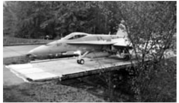
Ein F/A-18 rollt über die Ersatzbrücke.
