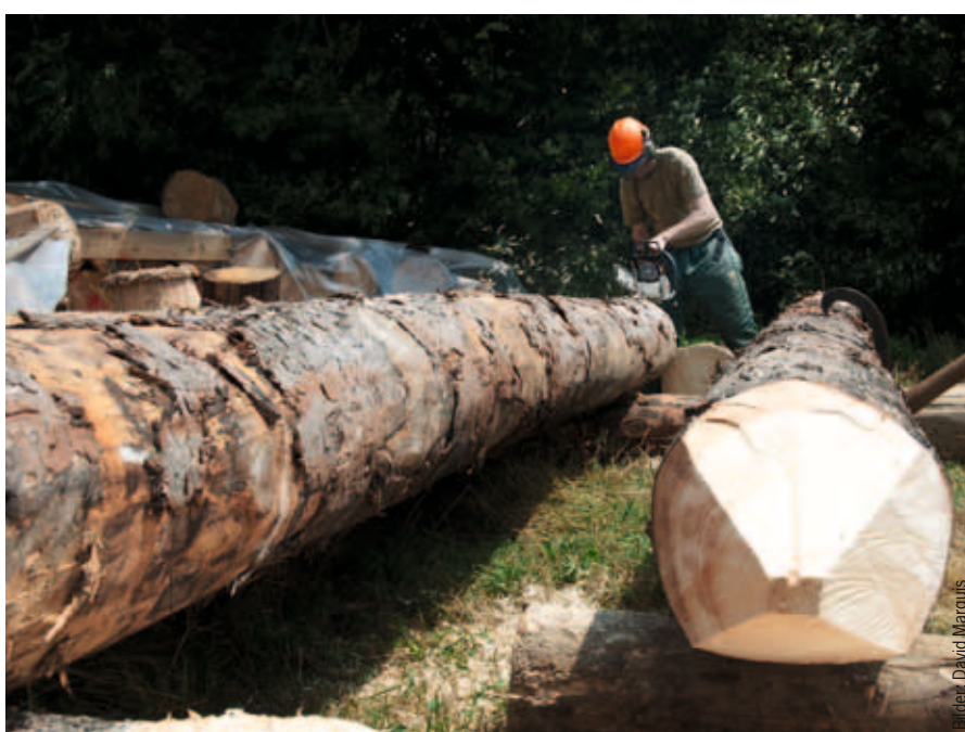
Mit der Kettensäge werden die Pfähle für den Brückenbau zurechtgeschnitten.
