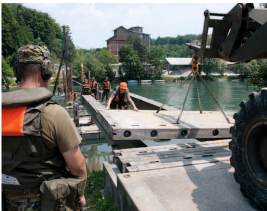
Die eingeflogenen Brückenelemente werden von den Genisten laufend verbaut.
