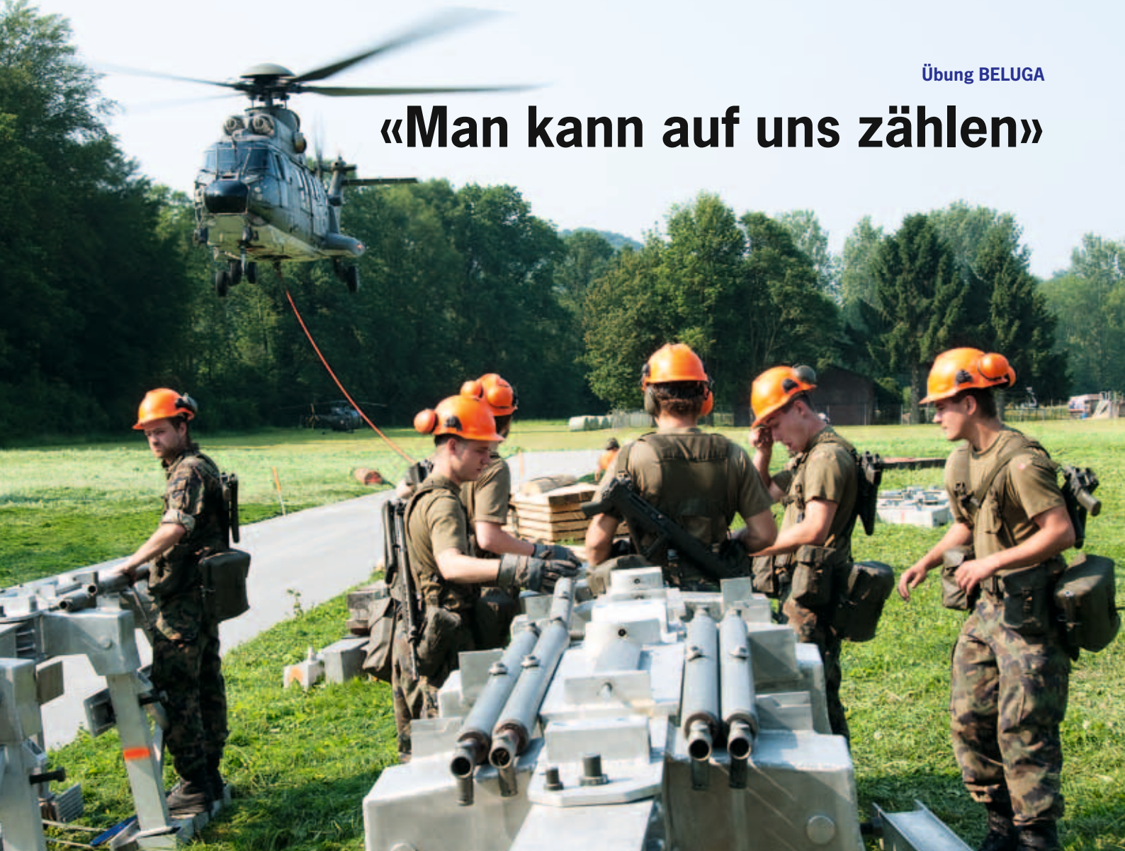
Die Elemente der Brücke wurden mit zwei Super Pumas eingeflogen.
