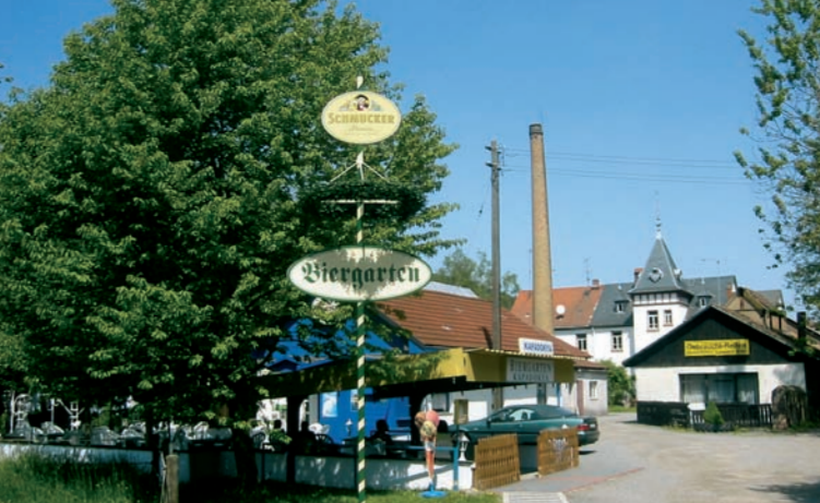
Ehemalige Lutmühle (zwischen Höchst und Mümling-Grumbach) ▲
