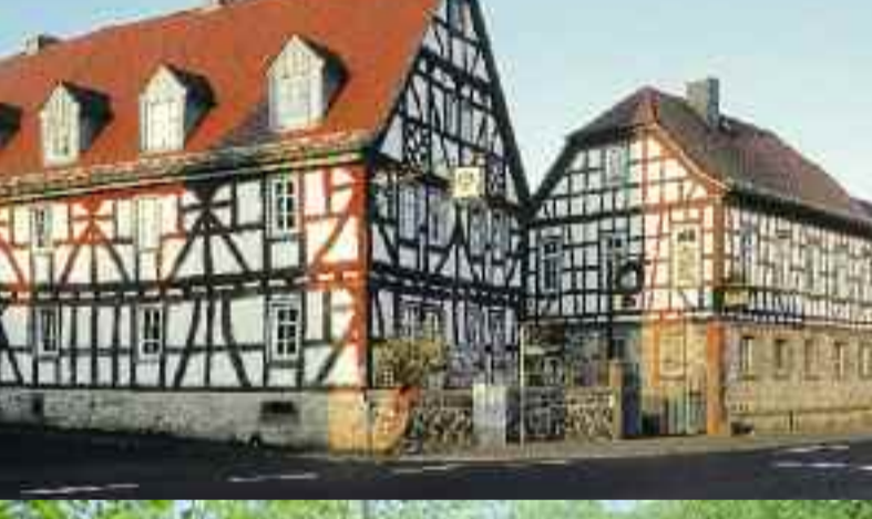
47 Abbildung Mitte: Fachwerkhäuser im Ortskern
